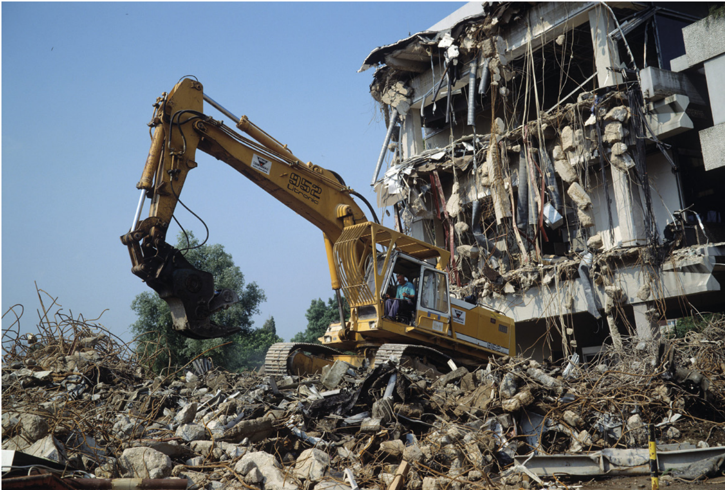
Wertvoller Rohstoff Bauschutt könnte in recycelter Form bald den knapper werdenden Strand- und Meeressand ersetzen. Bild: picture alliance/Sodapix AG
